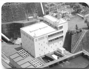
● 多摩川第1発電所
